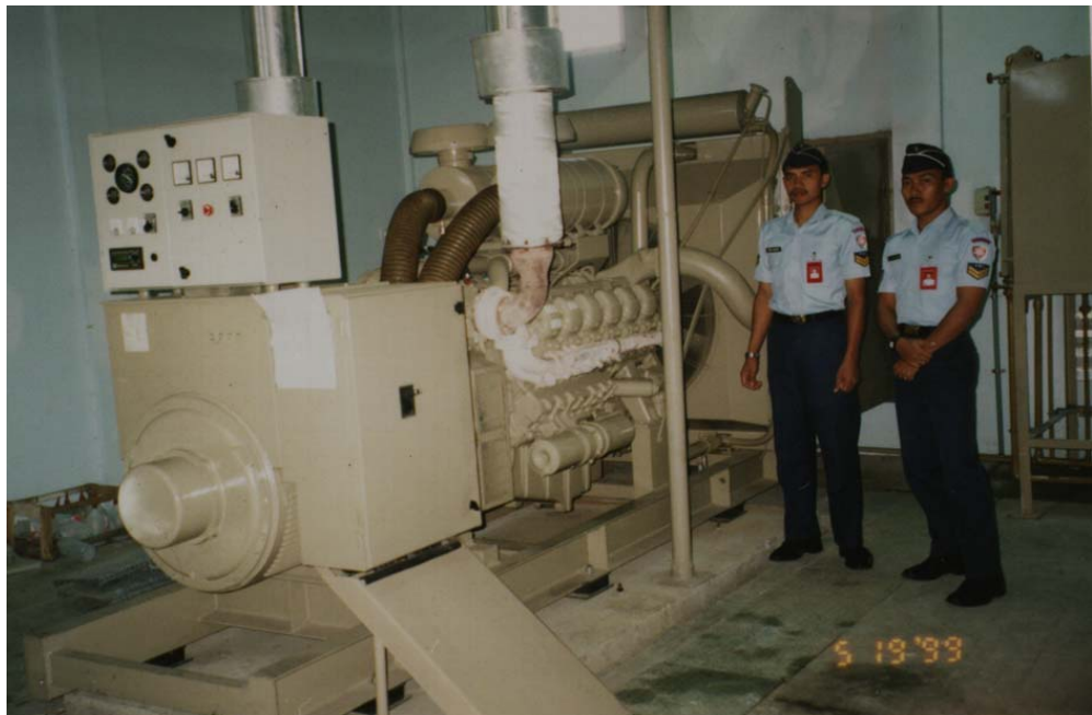
Gambar 14. Generator Set untuk kondisi darurat bersama dengan Sertu M. Taufik Kurniawan (kanan), salah seorang personel yang khusus menangani support equipment.
